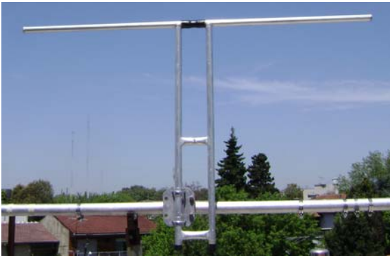
Antena en proceso de medición
